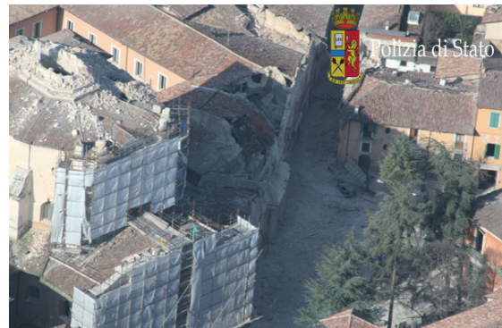
Santa Maria del Suffragio, con gli edifici adiacenti sventrati.
