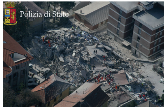
Veduta della Casa dello Studente, crollata quasi totalmente.
