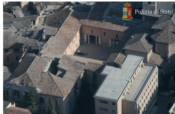
Gravemente lesionati gran parte degli edifici del centro storico.
