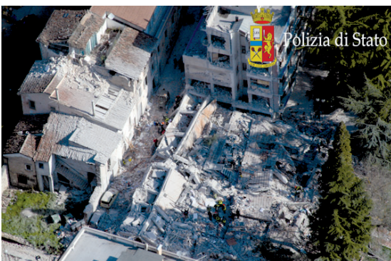
Un fabbricato totalmente accartocciato su se stesso a seguito del sisma.
